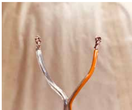
9. Separe os fios paralelos e desencape suas pontas. Se possível gire o fio exposto, de forma a aumentar sua área de contato.
